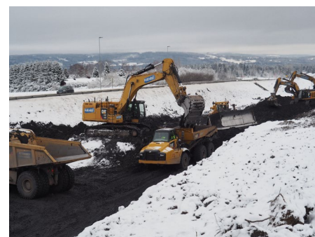
Anleggsarbeider ved Uthuskrysset i Stange. Foto: Nye Veier.
