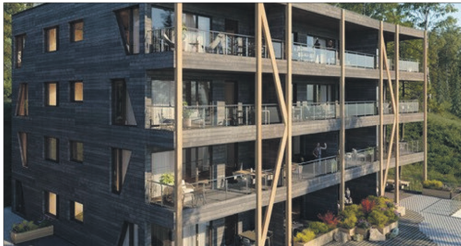
Pilotblokk i tre i Fetsund. Slik skal det bygges mange av i årene fremover.
