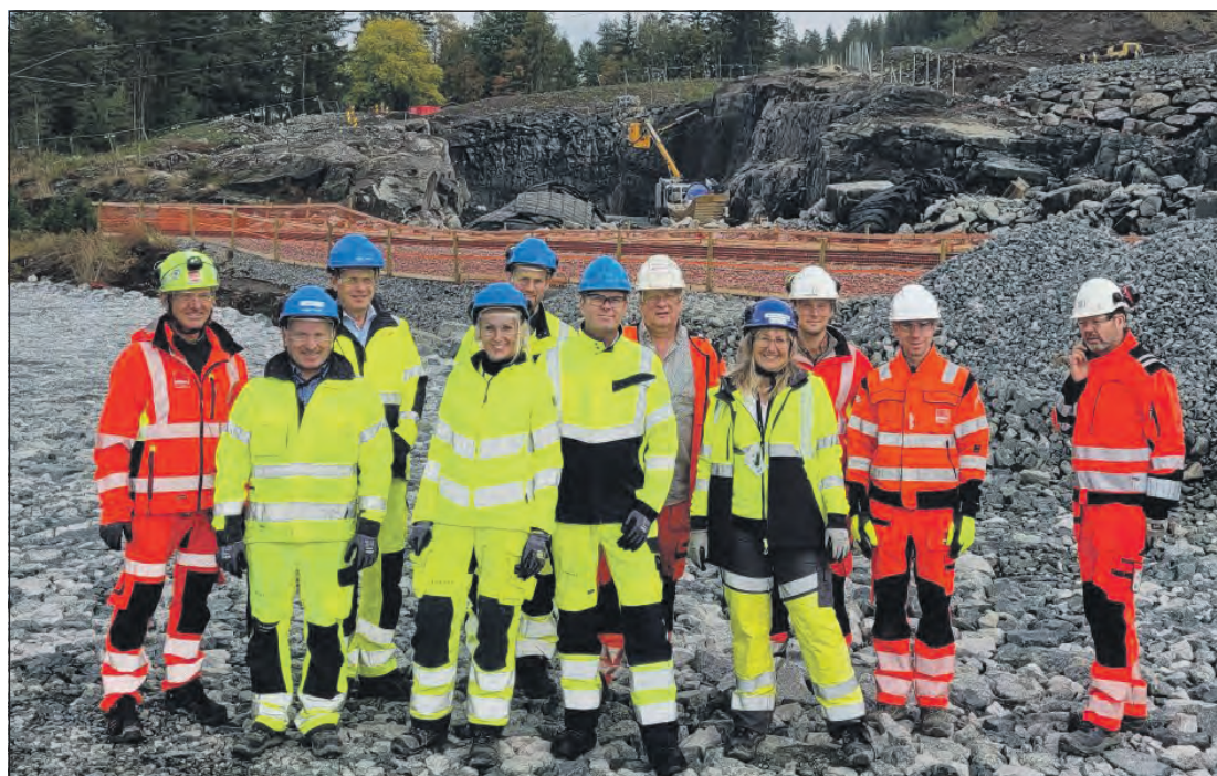
Representanter fra Veidekke og Bane NOR på befaring på den permanente fyllingen for nytt dobbeltspor. I bakgrunnen ligger byggegroppen der tunnelmunningen kommer. FOTO: BANE NOR
